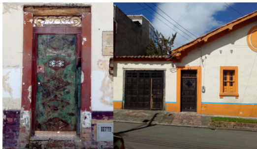
Figura 5. Detalles conservados de las fachadas
