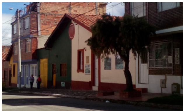
Figura 6. Fachadas originales y viviendas con modificaciones sobre calle 8ª
