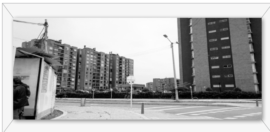
Figura 2. Conjuntos residenciales terminados y en proceso (Y. Gomez 2018)
