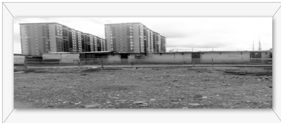
Figura 1. Cuartos de obra en proceso (S. Benítez 2018)
