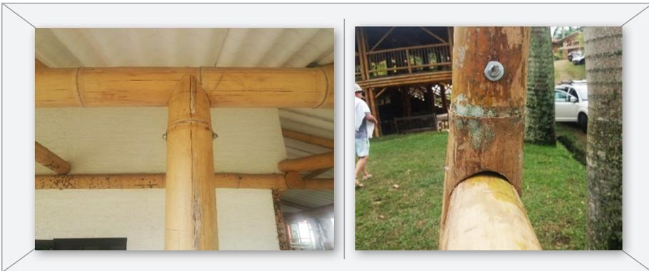
**Figura 13. Aspectos nocivos para elementos de guadua. Se evidencia rajadura del elemento en su eje longitudinal (izquierda), y presencia de hongos (derecha). Fuente: F. Sánchez, 2019**
