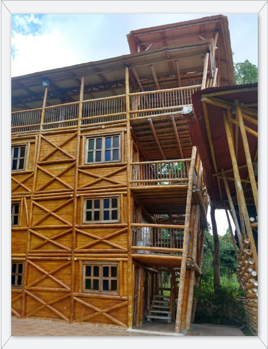
**Figura 12. Hotel de cuatro pisos construido en su totalidad en guadua a partir de pórticos con elementos transversales para control sísmico. Vereda La Cuchilla, Km 6,5 desde Alcalá vía Finlandia Quindío. Foto: F. Sánchez, 2019**
