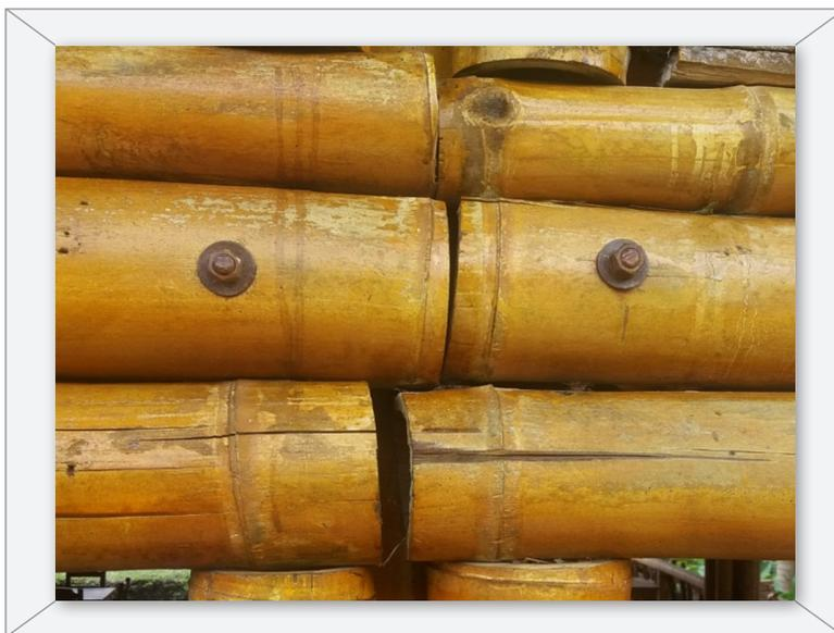
**Figura 14. Presencia de oxido en pernos y tuercas, lo cual disminuye la resistencia de la unión. Fuente: F. Sánchez, 2019**
