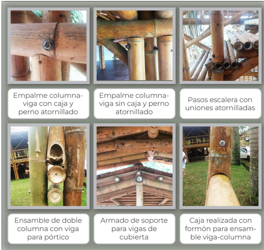
**Figura 11. Detalles de conexiones y ensambles de elementos en las estructuras de guadua. F. Sánchez, 2019**
