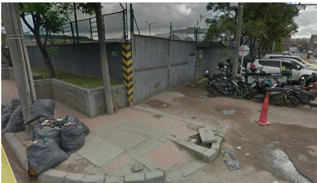
Ilustración 2. Acceso sobre la Carrera 65
