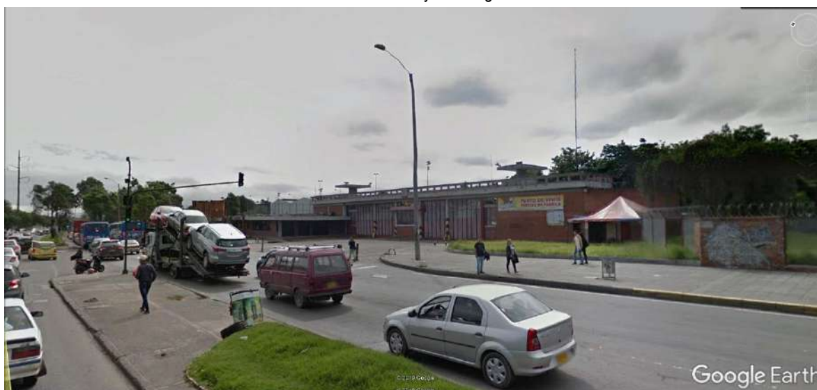
Ilustración 2. Acceso sobre la Avenida Boyacá antigua Cervecería Bavaria
