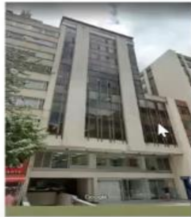
AÑO 2018-2024 EDIFICIO SAN JUAN
