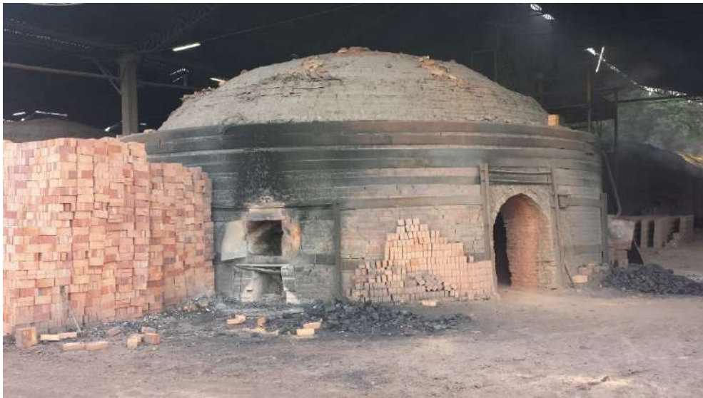
Figura 5. Horno colmena. Fuente: Archivo propio.
