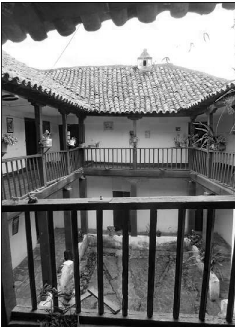
Figura 1. Casa colonial. Vista de las dos plantas y las crujiás que conforman la construcción. Fuente: Sánchez, 2014.
