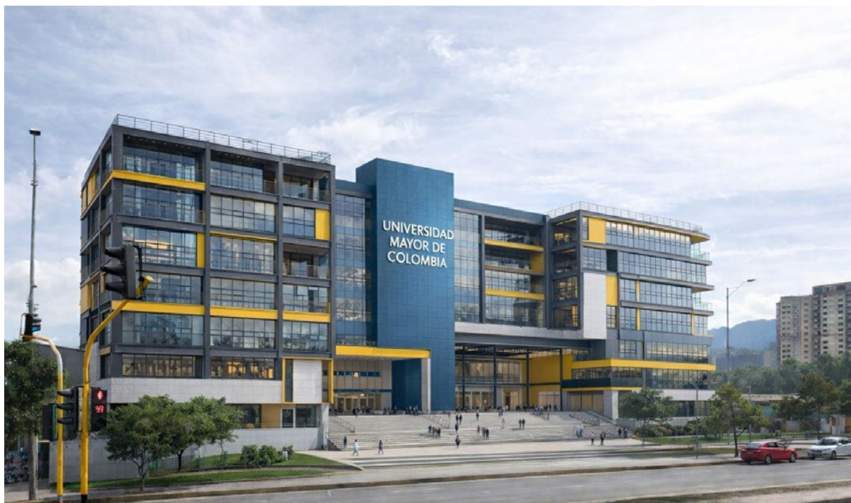
Esta es una proyección de lo que podría ser una fachada de la nueva sede sobre la Carrera 13, en el centro ampliado de Bogotá. Imagen: Generada por IA.
