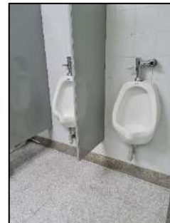
VISTA INTERIOR BAÑO
