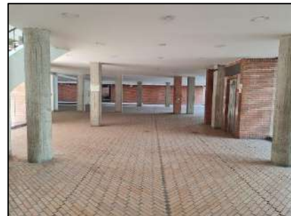
VISTA INTERIOR PRIMER PISO
